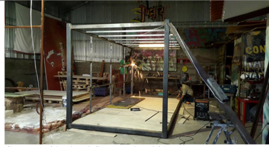
Construcción de El Contenedor, 2017.
