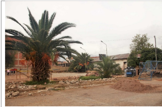
Aspecto del lugar de emplazamiento del Parque Urbano Ollantay antes de su construcción.
